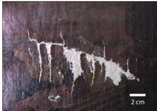
Abb. 186 Riss c/d: Kittung (Streiflicht)
