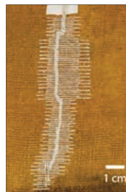
Abb. 176 Riss a/c, unten: Endzustand nach der Verklebung
