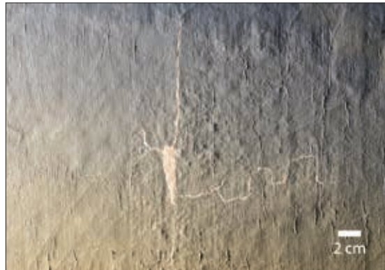
Abb. 188 Riss a/d: Kittung (Streiflicht)
