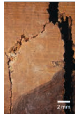
Abb. 80 Riss a/c, mittig: gefährdeter Risskantenbereich mit Malschichtausbrüchen
