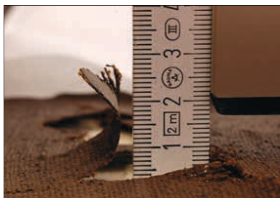
Abb. 145 Riss c/d: Seitenansicht Vorzustand
