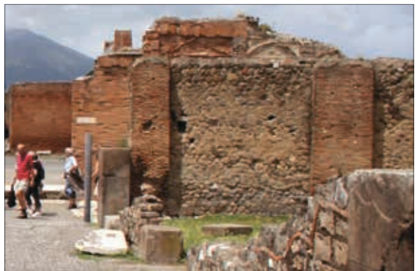
Abb. 29 Ansicht von heute (Mai 2013): Fassade an der Via dell' Abondanza
