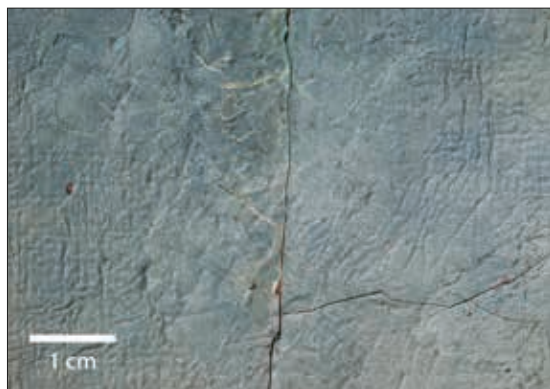
Abb. 120 Retusche und Kittung über Riss a/d, mittlerer Teil
