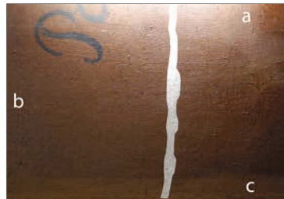
Abb. 161 Bereich B (Streiflicht): nach Behandlung der Deformationen
