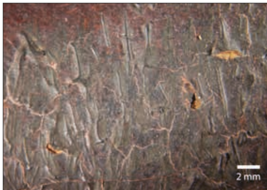
Abb. 79 Wiese, unten mittig: Malschichtausbrüche bis auf die Grundierung
