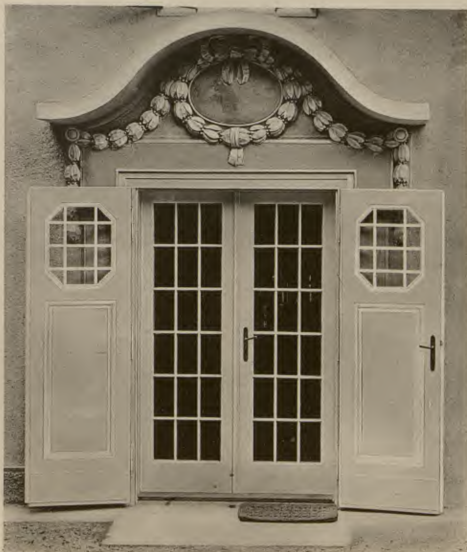
MÖDLING, HINTERBRÜHL, Eingangstür und Dachfenster.
